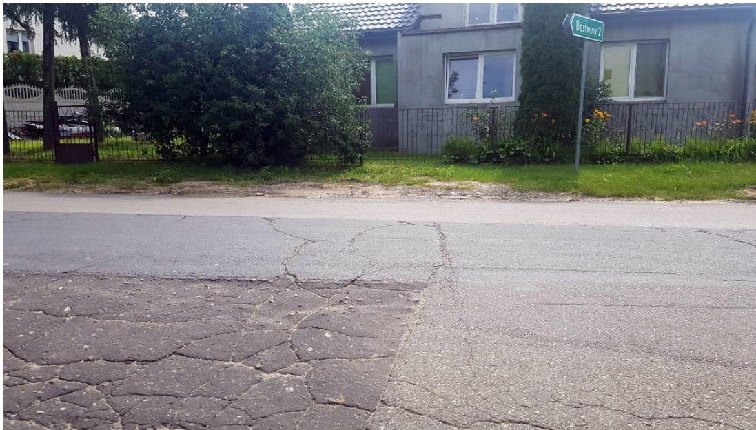
Fotografia 9 Stan nawierzchni drogi - przykład
