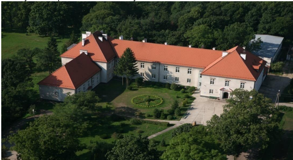
Fotografia 1 Budynek Zespołu Szkół w Siennicy
