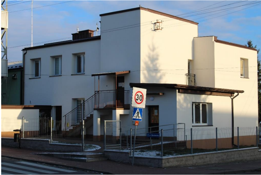
Budynek Gminnej Biblioteki i GOPS po termomodernizacji
