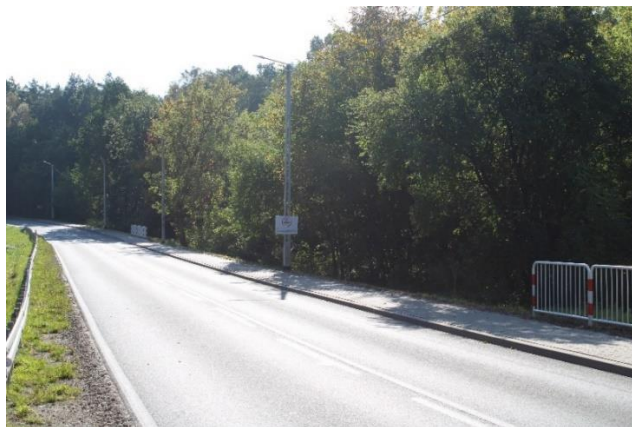
Oświetlenie uliczne Drożdżówka
