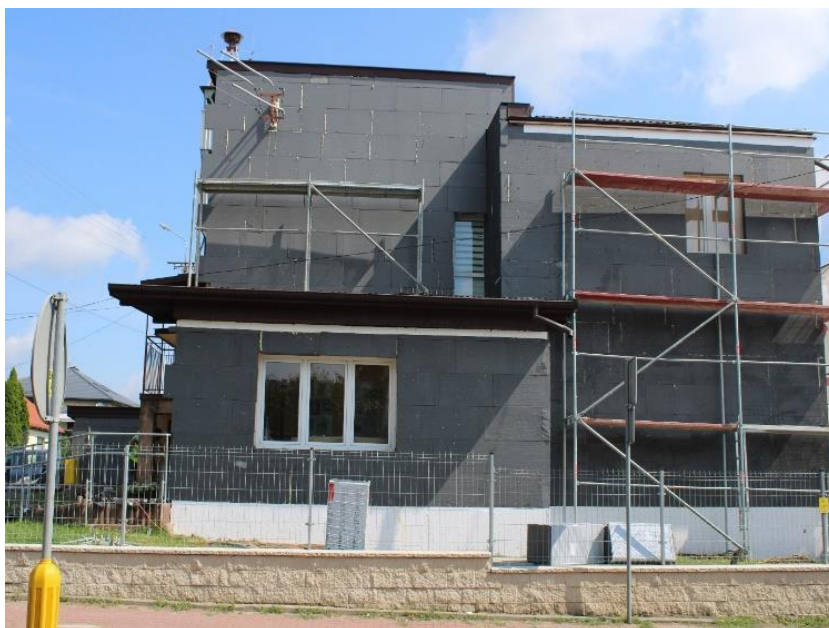
Budynek Gminnej Biblioteki i GOPS w trakcie termomodernizacji
